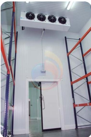
Cámara de refrigeración con evaporador de tiro forzado
