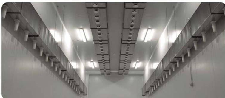
*Distribución del aire por mediante rejillas o toberas, dependiendo del tamaño y forma de colocar el producto.*
