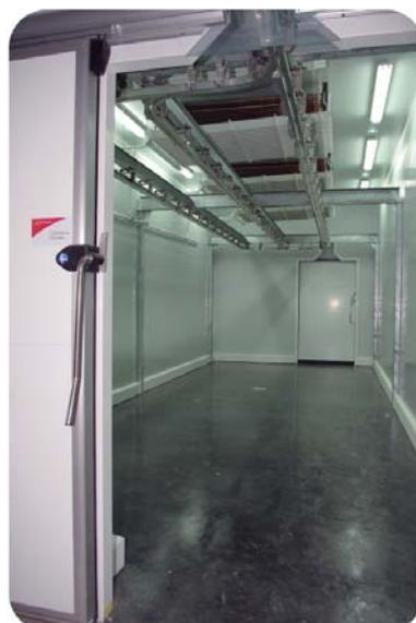
Cámara de refrigeración con evaporador estático
